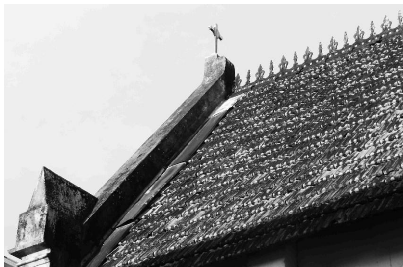
Fig. 65- Telhado. Foto acervo pessoal.
