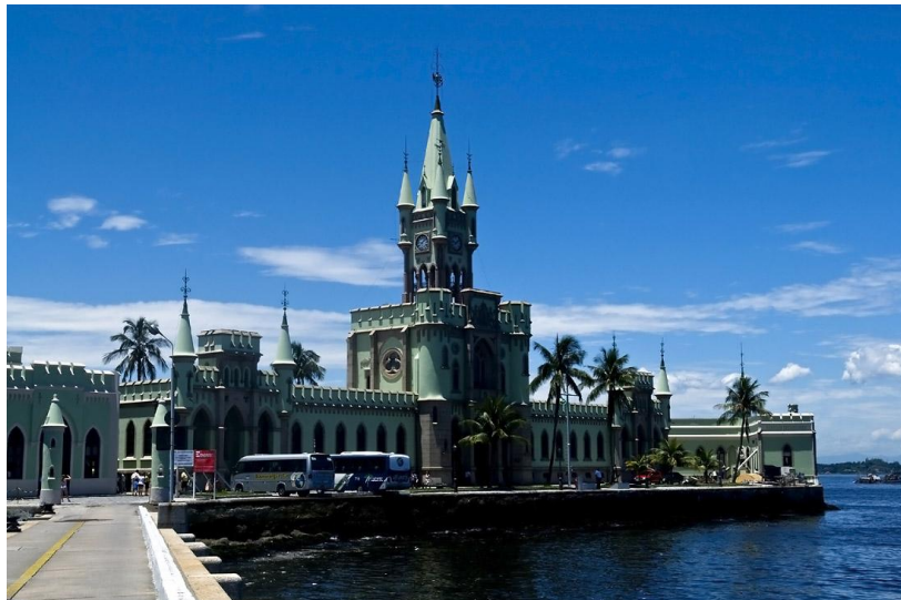
Fig. 30 - Prédio da Ilha Fiscal, Rio de Janeiro. Fonte: http://mapadecultura.rj.gov.br/rio-de-janeiro/real-gabinete-portugues-de-leitura/
