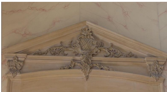
Figura 28: Triângulo adornado exposto acima das portas dos salões do segundo andar da Biblioteca. Fonte: PENHA, Ariadner Ester F. S., 21 de agosto de 2019. Acervo da pesquisadora.
