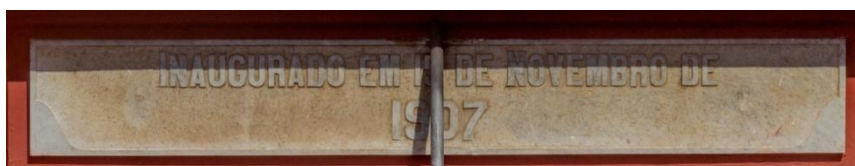
Figura 9: Placa da inauguração, Arquivo Público e Repartição da Estatística.
