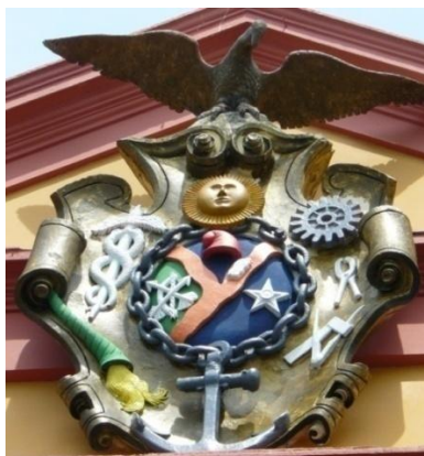
Figura 15: Brasão, exposto na fachada do edifício da Biblioteca. Fonte: Acervo cedido pelo Governo do Estado do Amazonas/SEC/Ateliê de Restauro, 2013.
