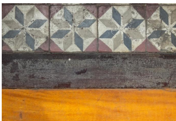
Figura 36: Piso original, entrada do Salão Thália Santos, andar térreo da Biblioteca. Fonte: PENHA, Ariadner Ester F. S., 21 de agosto de 2019. Acervo da pesquisadora.
