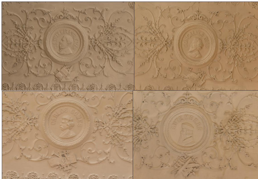
Figura 33: Medalhões expostos no forro estucado, teto do andar superior da Biblioteca.
