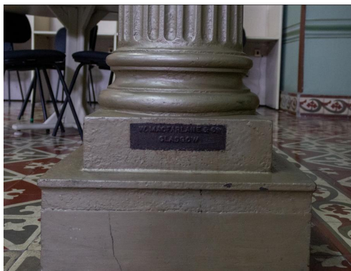
Figura 30: Base de coluna, com a marca do fabricante Walter Macfarlane. Fonte: PENHA, Ariadner Ester F. S., 21 de agosto de 2019. Acervo da pesquisadora.
