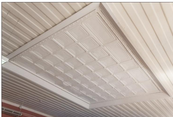
Figura 35: Parte do forro original, teto do salão Lourenço Pessoa, andar superior da Biblioteca. Fonte: PENHA, Ariadner Ester F. S., 21 de agosto de 2019. Acervo da pesquisadora.
