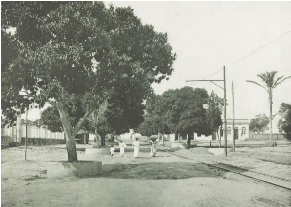
Figura 30 - Estrada Epaminondas, antiga Estrada da Cachoeira Grande. Aqui os trilhos de bonde à frente do Cemitério de São José podem ser observados mais nitidamente, à direita, e parte dos muros e gradis da necrópole estão visíveis à esquerda.
