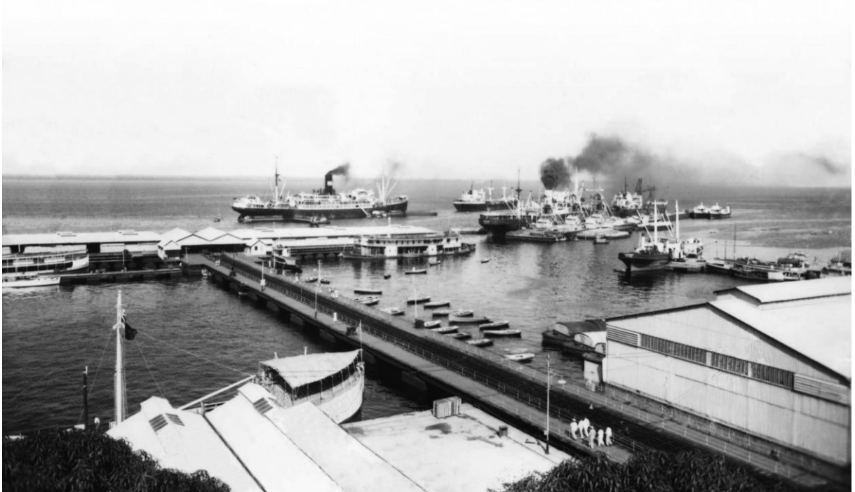
Figura 10 – Roadway/Ponte flutuante do Porto de Manaus
